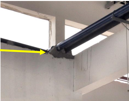
Gambar 2.14 Paip Dipasang Tidak Kemas
