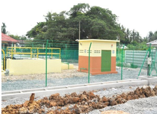
Gambar 2.1 Loji Rawatan Kumbahan Yang Belum Siap Dibina
