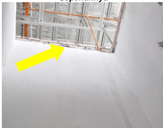
Gambar 2.16 Dinding Bilik Bomba Tingkat Satu Pasar Kering Tidak Dibuat Lekaan Simen Sepenuhnya
