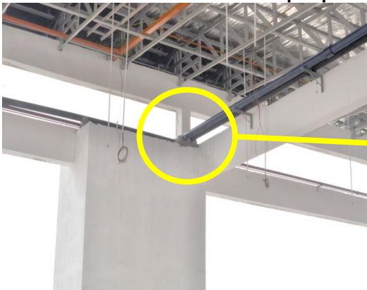
Gambar 2.14 Paip Dipasang Tidak Kemas
