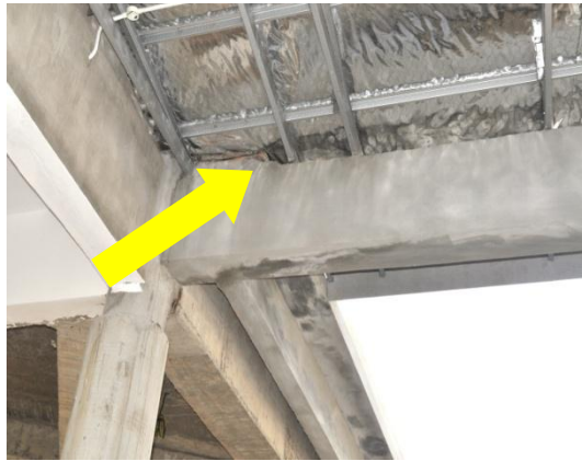
Gambar 2.13 Kerja Kemas Lekaan Pada Bumbung Laluan Dari Pasar Kering Ke Pasar Basah Tidak Kemas
