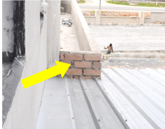
Gambar 2.9 Bumbung Atas Walkway Tidak Dibuat Lepaan Simen Sepenuhnya
